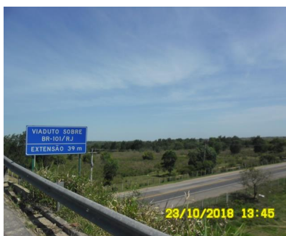
Foto 5.4-79: Placa de sinalização no início do lado do viaduto.
