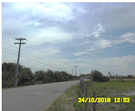
Foto 5.4-3: Estaca 45. Traçado cruzando estrada asfaltada e posteamento de energia.
