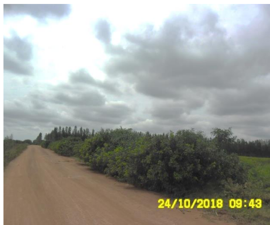
Foto 5.4-38: Ponto onde o traçado passa pela estrada de terra na altura da estaca 700.
