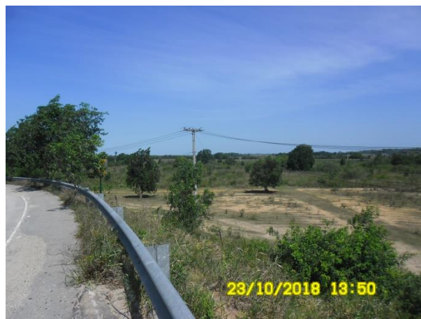
Foto 5.4-78: Ponto onde o traçado passa pelo viaduto na BR-101 com posteamento de energia e campo de pastagem apresentando árvores e arbustos isolados no caminho, ao fundo. Altura da estaca 1960.
