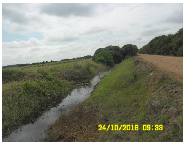
Foto 3.7-5 – Canal de drenagem paralelo a estrada de terra próximo ao traçado, na altura da estaca 750.
