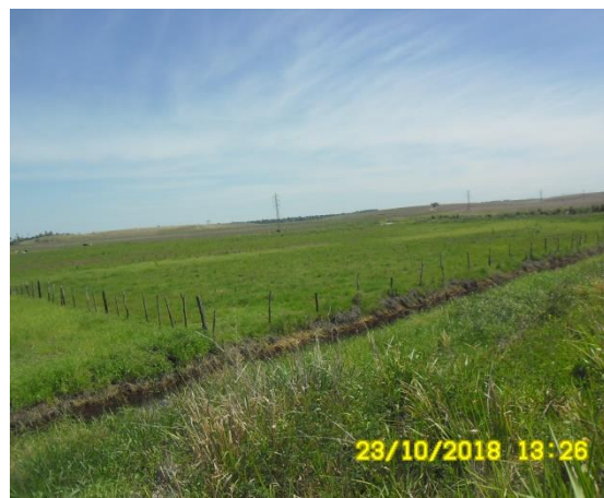
Foto 5.4-82: Canal de drenagem acompanhando traçado lindeiro à estrada Morro Itaóca, na altura da estaca 2040.
