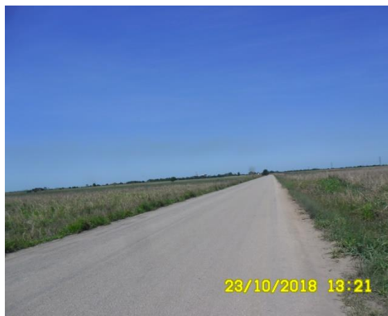
Foto 5.4-81: Traçado acompanhando a pista na estrada Morro de Itaóca na altura da estaca 2050.
