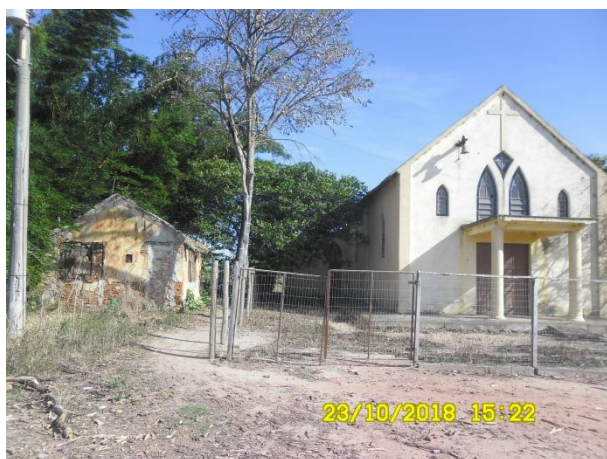
Foto 5.2.1-9: Igreja fechada com edificação abandonada, ao lado, mostrando sinais de comprometimento da estrutura. Edificações localizadas a cerca de 500 m do traçado no bairro Coqueiros de Tócos.
