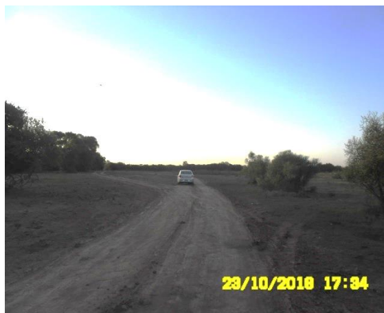
Foto 5.4-56: Ponto onde o traçado cruza estrada de terra na altura da estaca 990.
