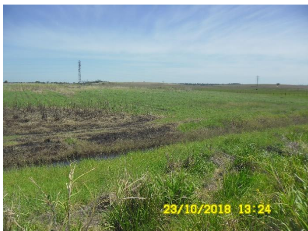
Foto 4.2-3: Detalhe para a presença de canal de drenagem localizado nas adjacências da estaca nº 2050 do projeto.
