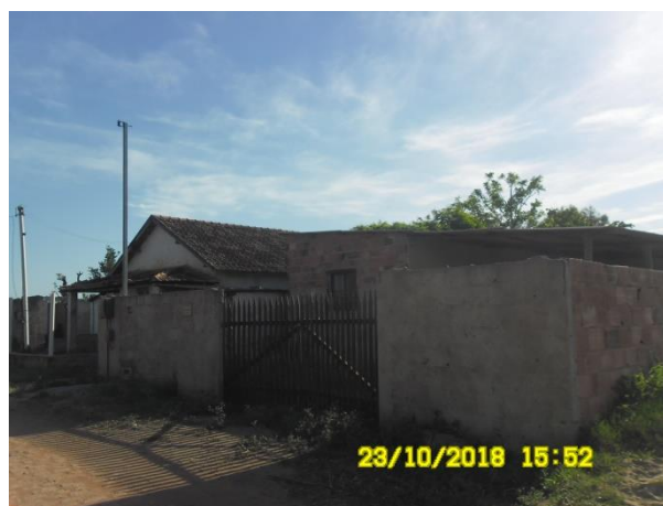
Foto 5.2.1-8: Residência ao longo da Ca-Quarenta, dentro do AID do empreendimento, cerca de 350 m do traçado na altura da estaca 1360.
