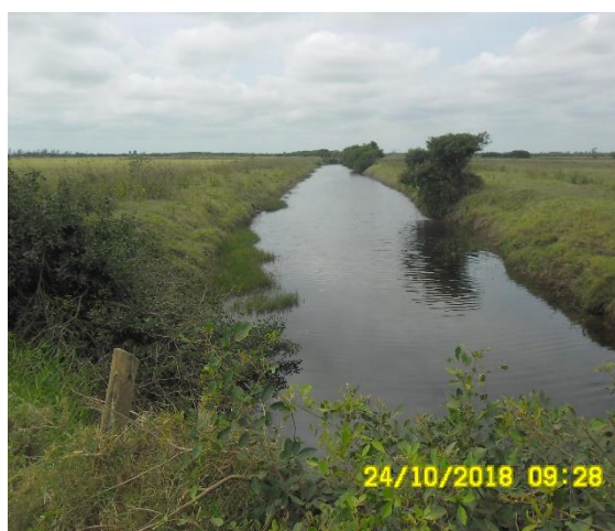
Foto 3.7-3 – Curso d'água na altura aproximada da estaca 765.
