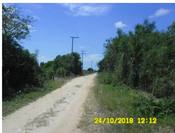
Foto 5.4-11: Ponto onde estrada de terra interceptada pelo traçado na altura da estaca 265.
