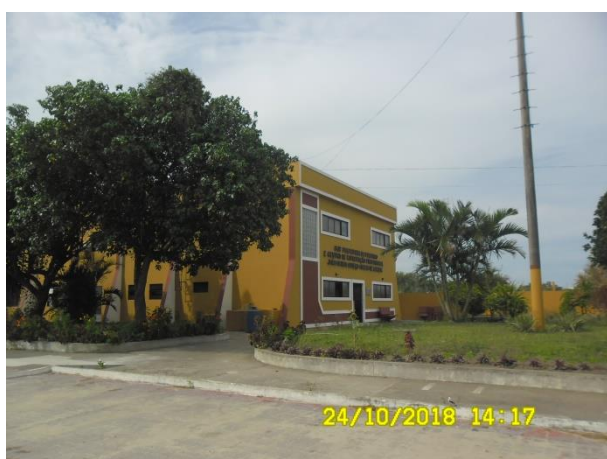
Foto: 5.2.1-3: subprefeitura de São João da Barra, no Distrito de Pipeiras, a cerca de 300 m do traçado na altura da estaca 300.
