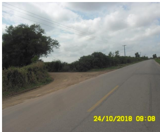
Foto 5.4-51: Ponto onde o traçado que acompanha estrada de terra cruza a rodovia RJ-196 e posteamento de energia na altura da estaca 835.
