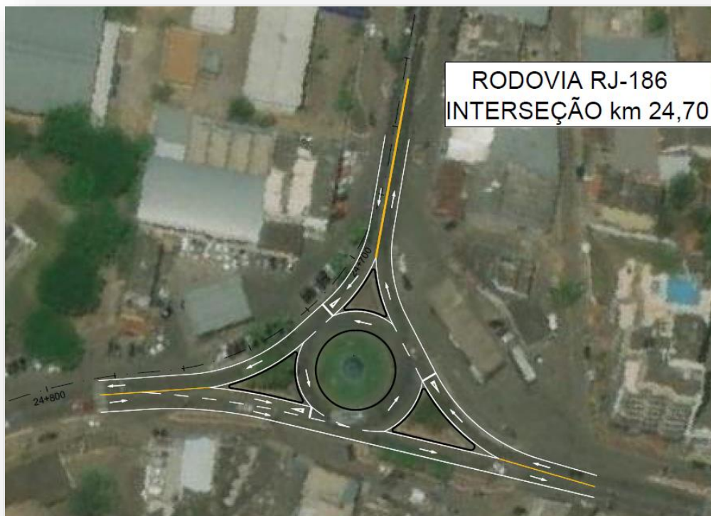
Figura 59 - Interseção km 24,70 | RJ-186
