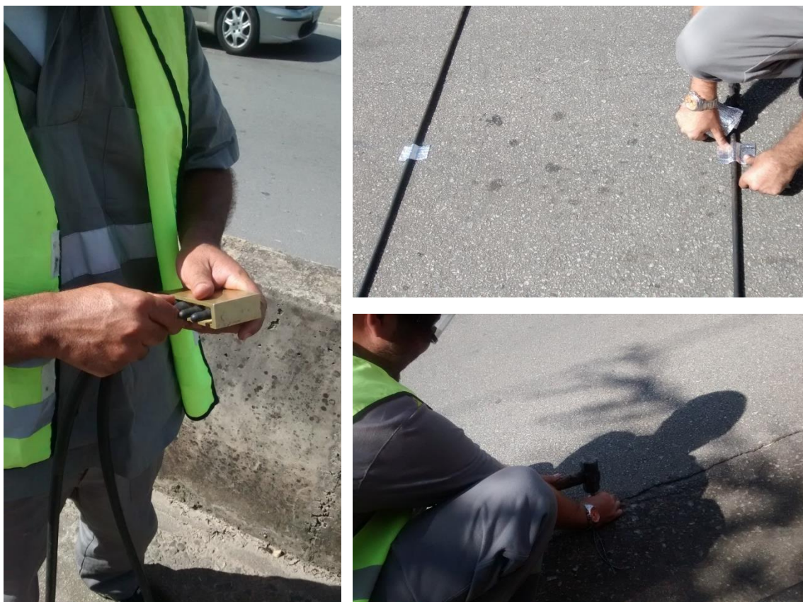
Figura 9 – Instalação do Picocoounter 2500 juntamente com as mangueiras de ar.
