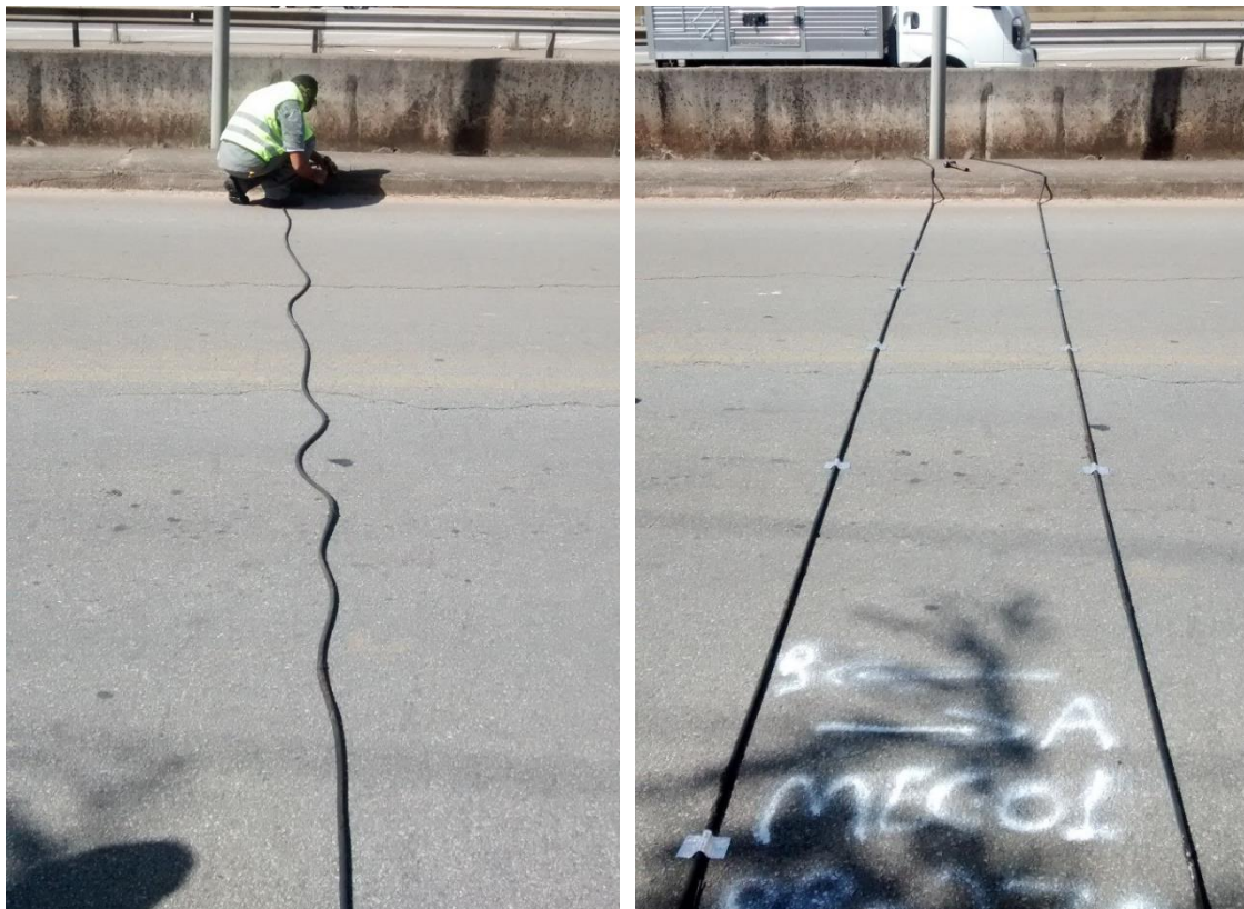
Figura 8 – Instalação das mangueiras de ar para o funcionamento do Picocounter 2500.
